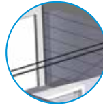
Tubazione del refrigerante
