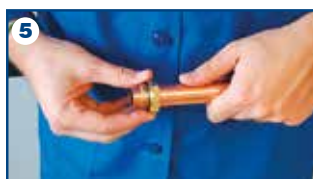
5 Posizionamento corretto per punzonatura
