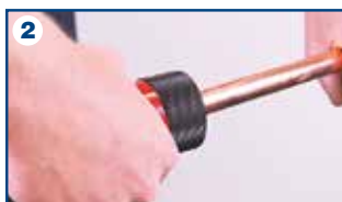
2 Sbavare esternamente il tubo
