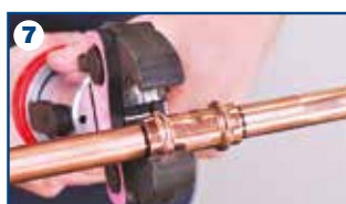
7 Completare il ciclo di pressatura. Pressare una sola volta
